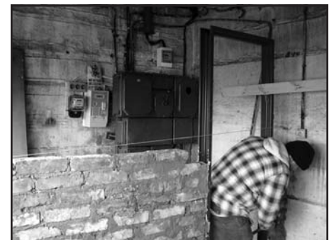
Rafal installing a door frame
